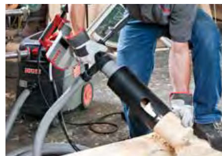
FORAGE DANS LE BOIS avec aspiration des poussières, à main
