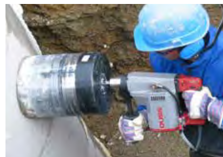
FORAGE DE RACCORDEMENT DANS CANALISATION EN BÉTON , à eau et à main
