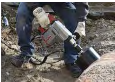
FORAGE DANS CANALISATION en matières plastiques, à sec et à main
