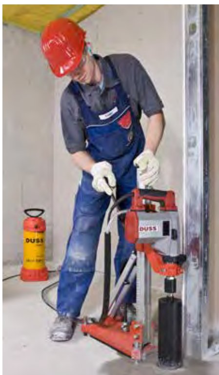
FORAGE DANS LE BÉTON , à eau et avec support BS
